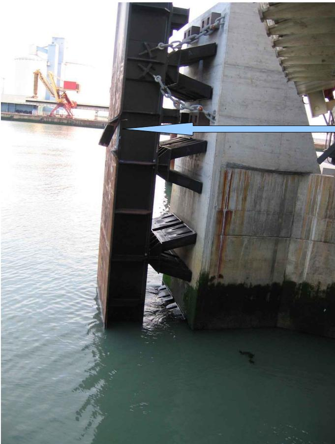
Bouclier d'embecquetage du poste 9 endommagé suite à l'appareillage du SEAFRANCE RENOIR. D'autres dégâts non apparents sur ce cliché rendent la réfection du bouclier indispensable à une exploitation dans des conditions optimales du poste.
